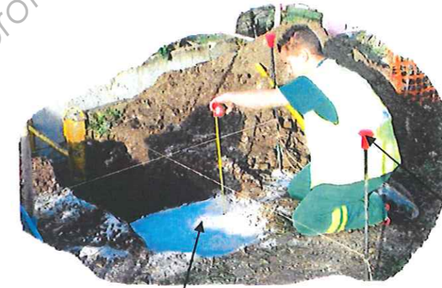
Réglage du lit de pose pour le fond de regard
